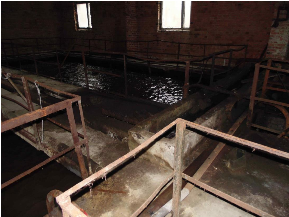
Рисунок 1.2.4 - Здание блока биологической очистки
