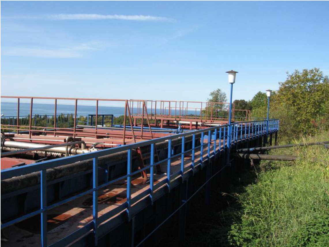
Рисунок 4.4.1 - Блочные очистные сооружения.
