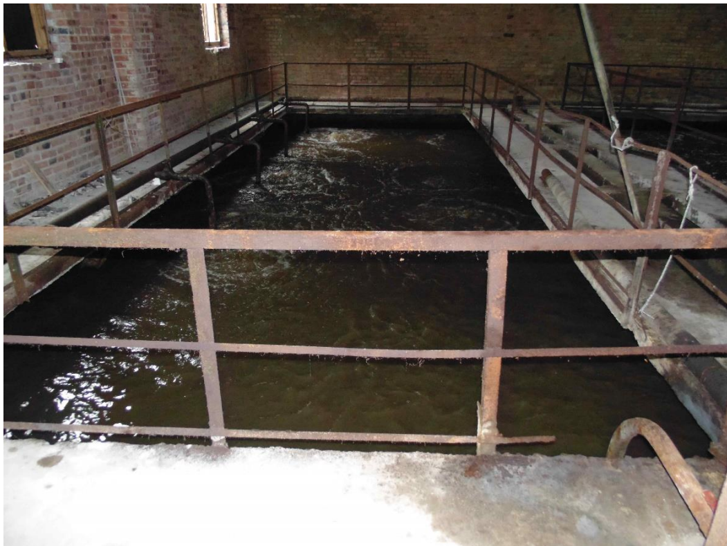
Рисунок 1.2.5 - Аэротенки – отстойники
