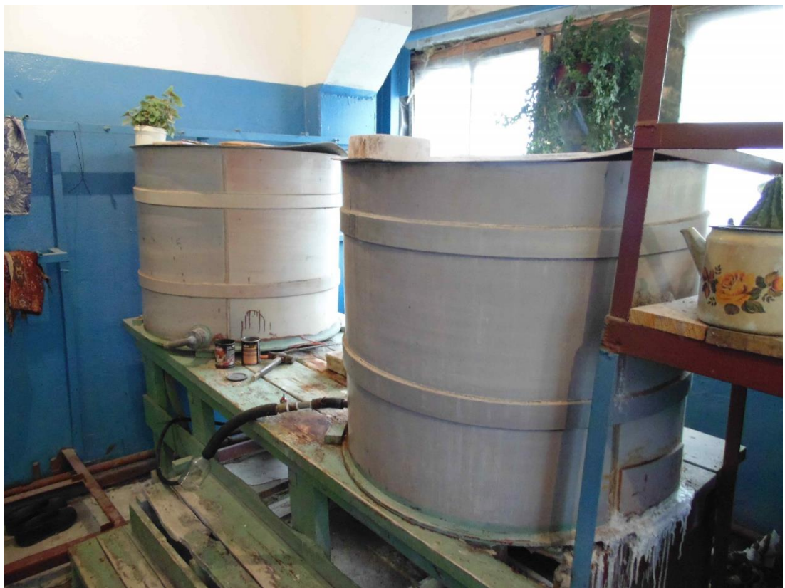
Рисунок 1.5.2 - Фильтры очистки
