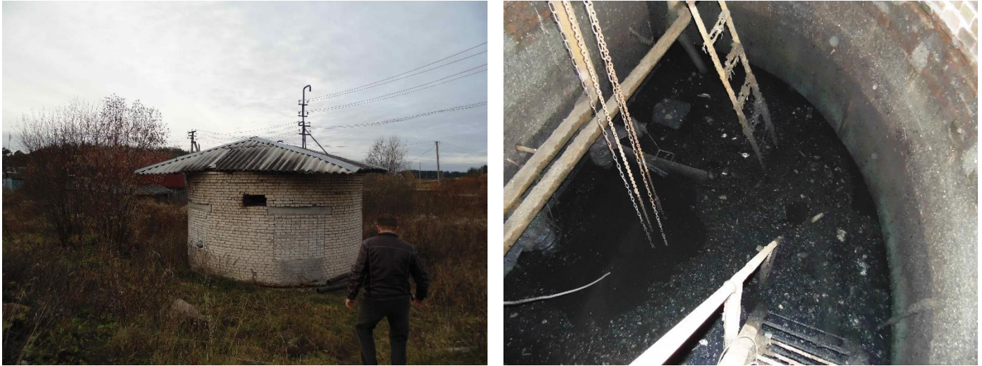
Рисунок 1.2.1 Здание КНС и приемный резервуар
